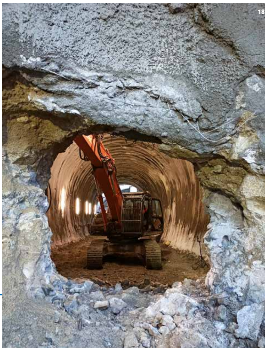
18. Completamento scavo gallerie di sottoattraversamento dell'Isarco: 6/11/2020
